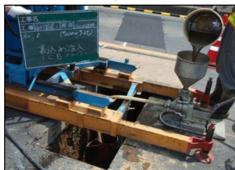
11・山留め管と取付管の隙間にポンプにて裏込め材を注入する様子を撮影します。
