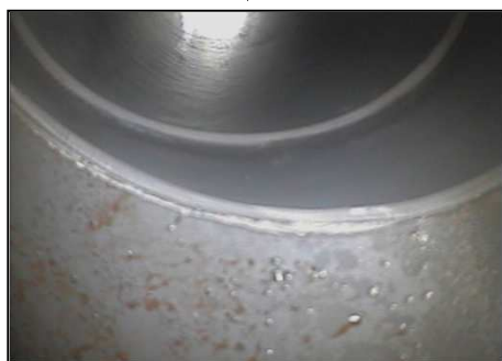
10・挿入したカメラにて取付管内部の接続部分を撮影します。
