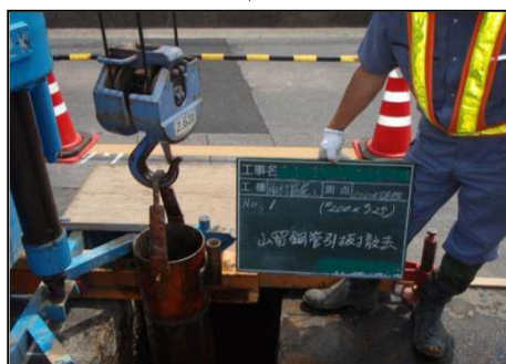
12・裏込め材注入後、山留め管の引抜状況を撮影します。
