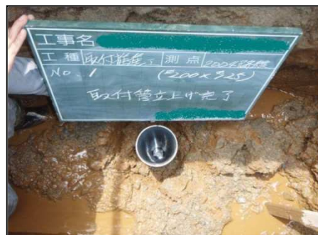
13・推進作業終了時の取付管の立ち上がりを撮影します。
